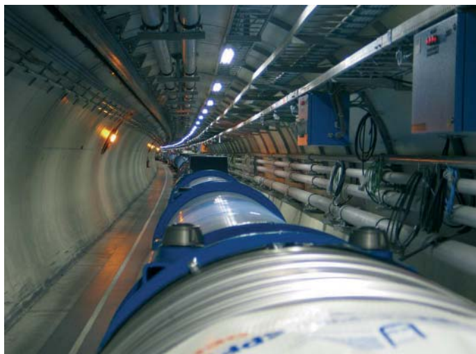
Imanes de deflexión (dipolos). Cada dipolo pesa unas 35 T, son necesarios unos 1232 dipolos.
